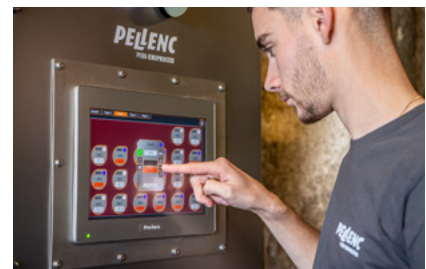
Steuerung einer Lesegutannahme mit ganzen Trauben, mit Beschickung der Pumpen über Türen
