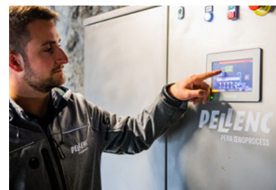
Steuerpult für das Management der Tanktemperaturen
