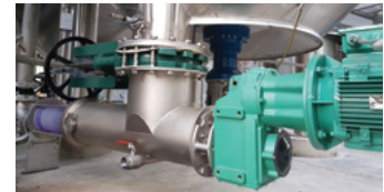
PHC: Pumpe mit Flansch, Verwendung unter Tank
