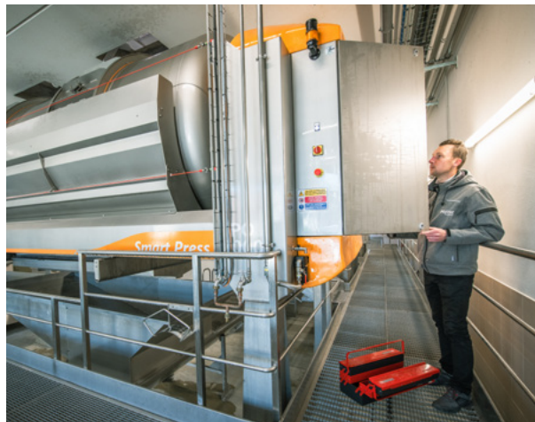
Installation von Pressen mit Belons
