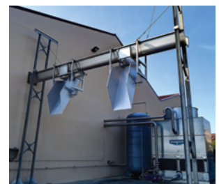
Tresteraustrag per Förderschnecke mit Tragsystem und Rinne zum Füllen der Mehrfachwannen – pneumatische Steuerung der Rinnen und Klappen
