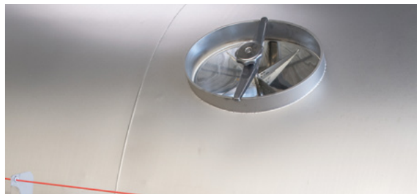
Mannloch für den Zugang zur Luftseite der Membran
