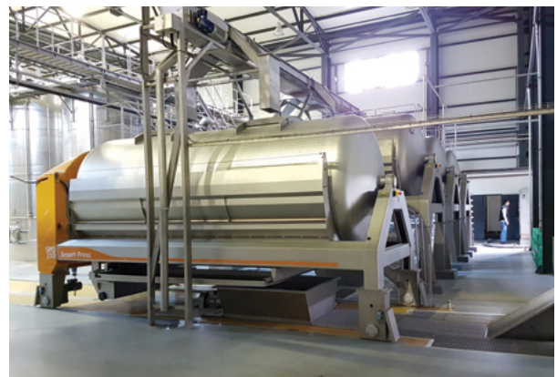
Tresteraustrag per Förderschnecke
